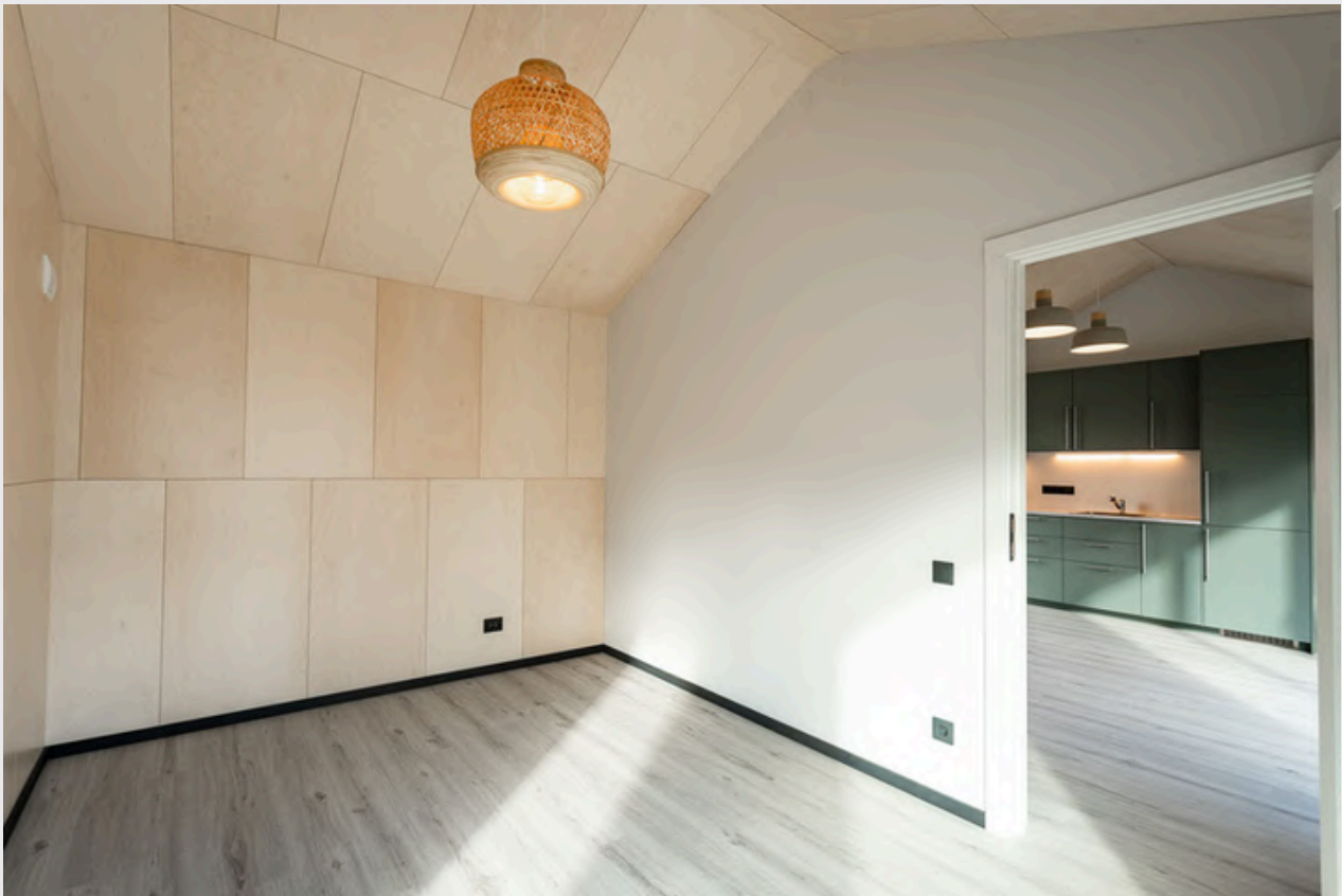
MODELL IDA MED EN BLANDING AV KRYSSFINÉRPLATER OG GIPS PÅ VEGGENE
